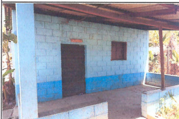
Foto 4: Mejoramiento de techo, cocina y piso.
