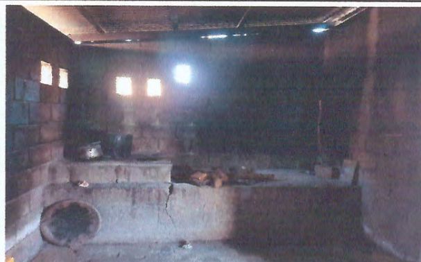
Foto 2: Reparación de área de cocina (polleton y salida de humo)
